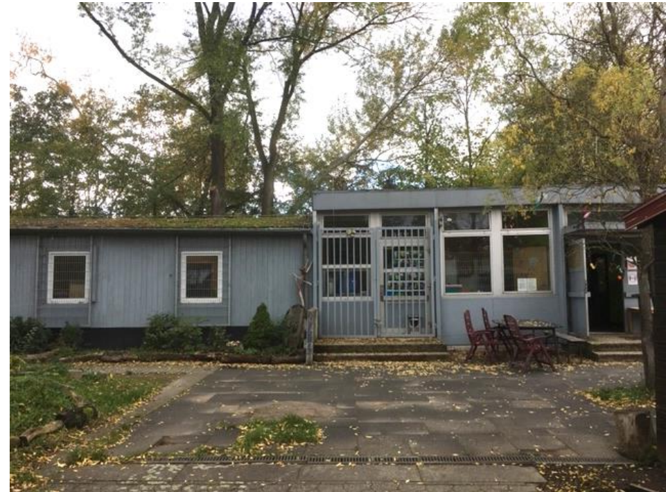
Weist Erneuerungsbedarf auf: Der Gebäudebestand des beliebten Abenteuerspielplatzes „Tempoli“
